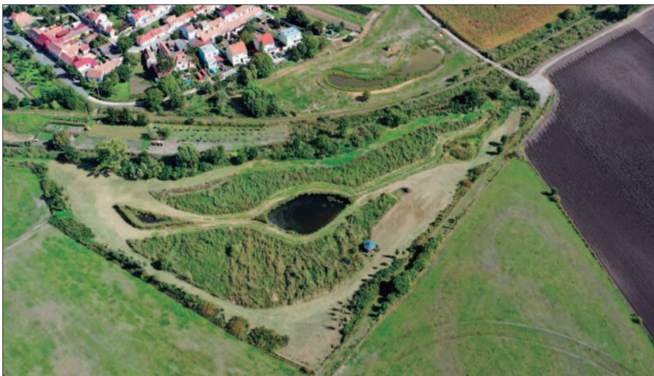
Stav po realizaci společného zařízení
