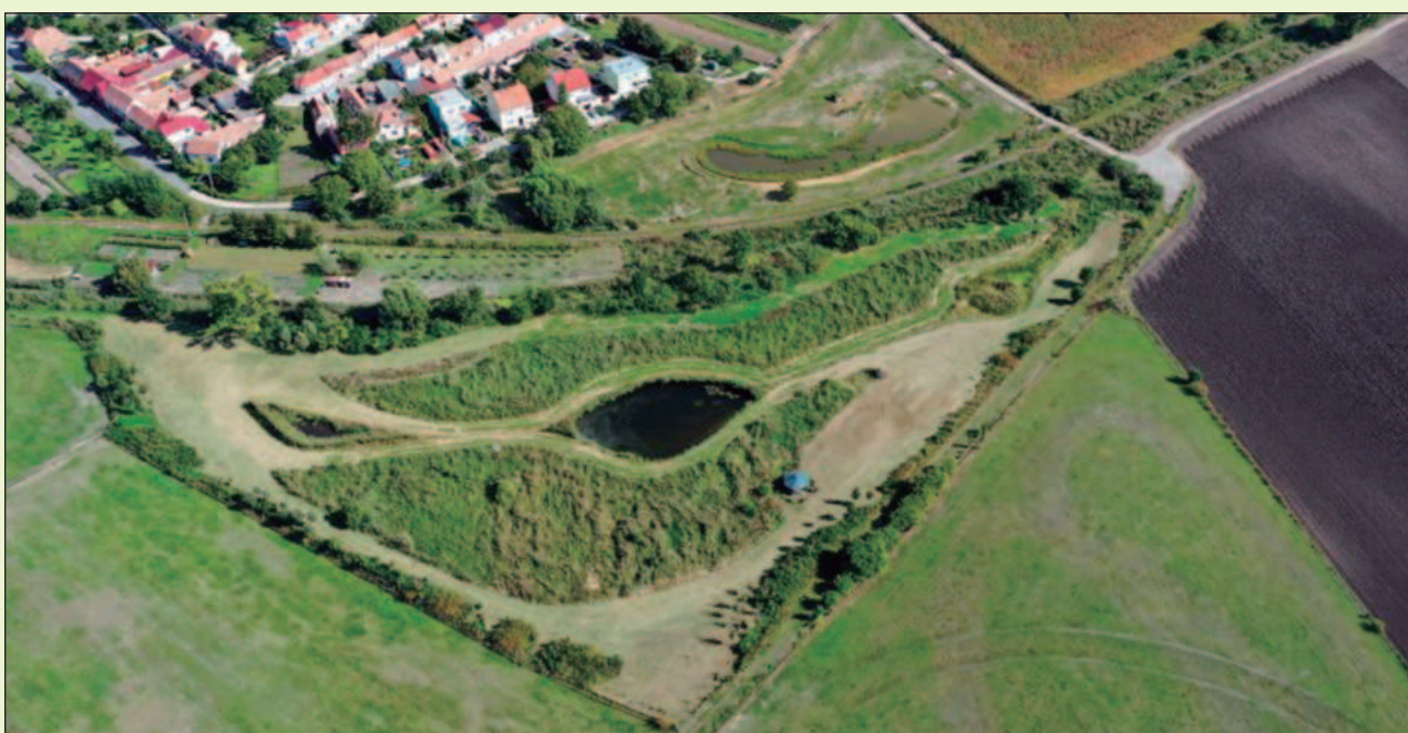
Stav po realizaci společného zařízení
